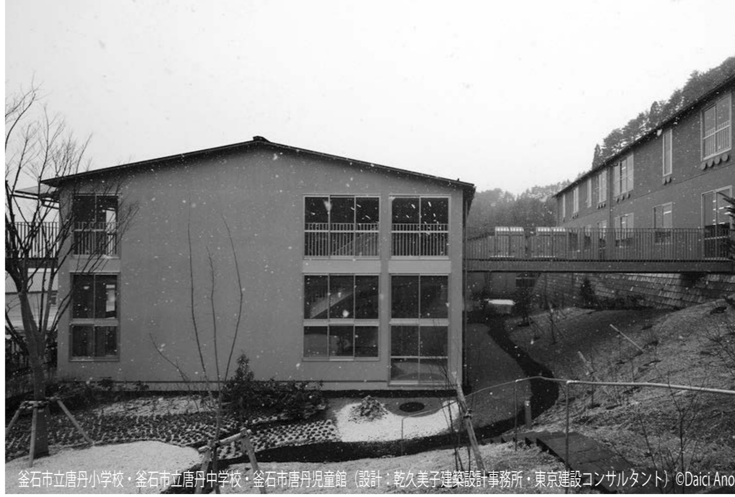
釜石市立唐丹小学校・釜石市立唐丹中学校・釜石市唐丹児童館（設計：乾久美子建築設計事務所・東京建設コンサルタント）©Daici Ano
