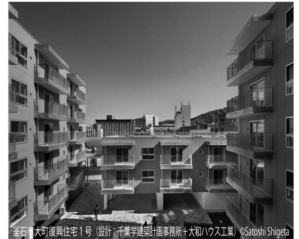
釜石市大町復興住宅1号（設計：千葉学建築計画事務所・大和ハウス工業）©Satoshi Shigetani
