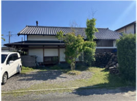
図 1 外観写真（住宅 4）
